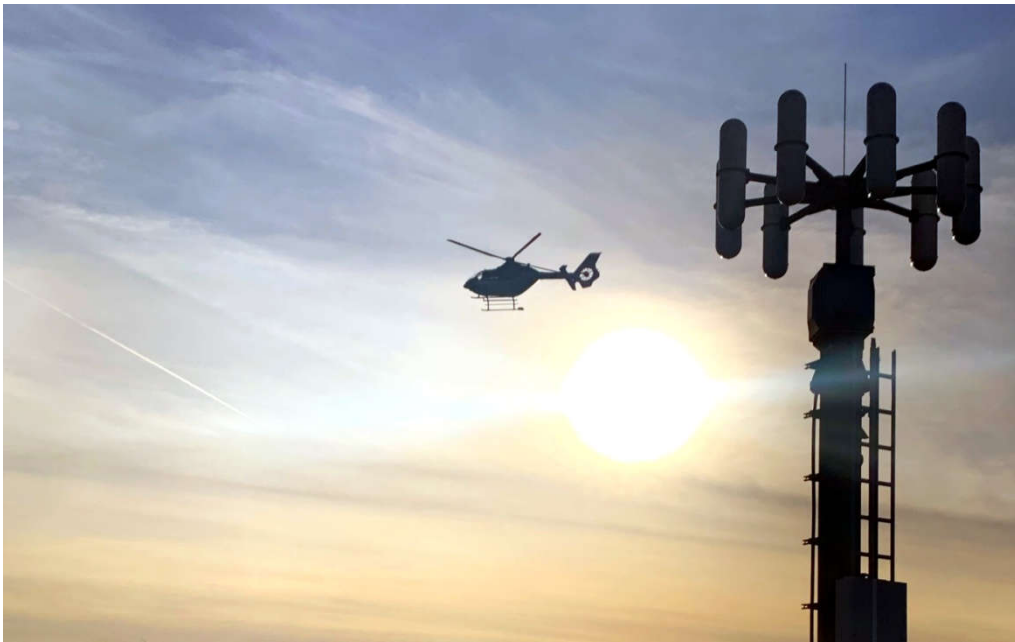
Feldinstallation des IZT R5509 Peilers in Wagenhausen.
