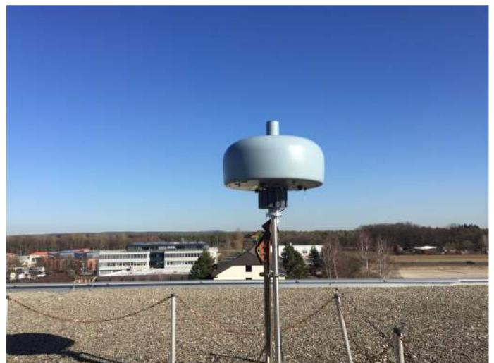
FIGURE 18: INSTALLATION OF IZT R5506 RADIO DIRECTION FINDER
